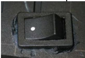
L'usinage pour l'implantation de l'interrupteur n'a pas les bonnes dimensions.
