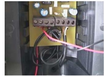
Fixation des câbles dans le bornier
